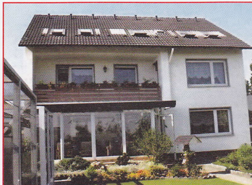
Gut zu erkennen sind die Einflüge der Reiseschläge auf dem Dachboden.
